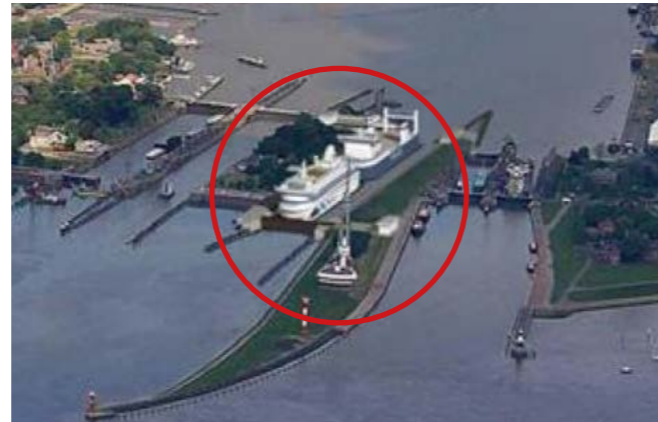
Brunsbüttel Schleusen 2019 virtuell fertig
